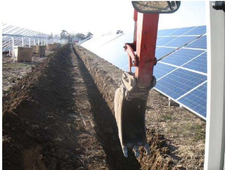
Photo 19. Exemple de tranchée entre deux tables photovoltaïques
