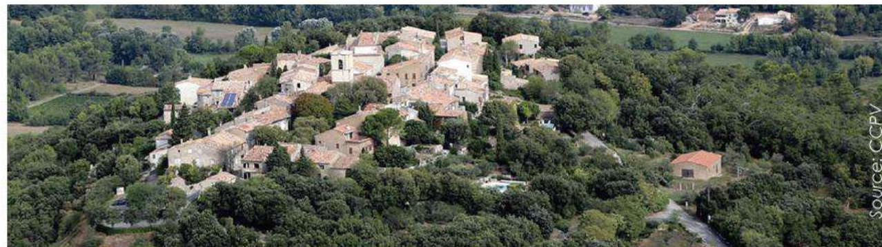
- PROJET PHOTOVOLTAÏQUE A FOX-AMPHOUX - EPURE PAYSAGE -
