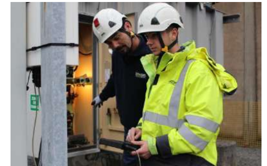
Photo 21. Mise en service par ENEDIS
